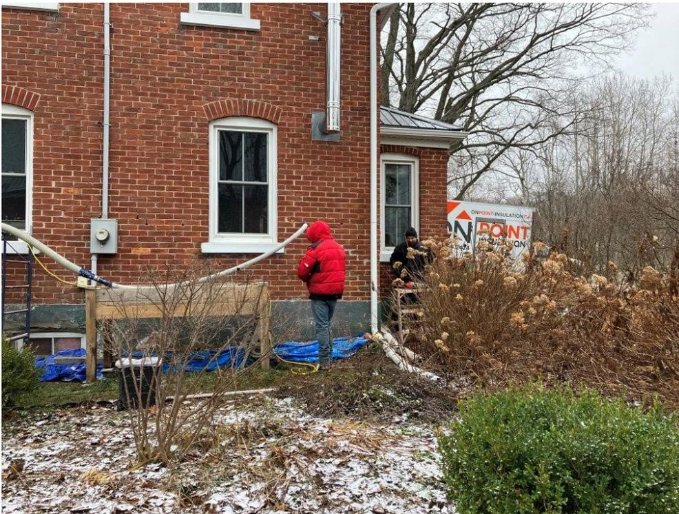
Les entreprises d'isolation procèdent au pompage extérieur de l'isolant cellulosique.
